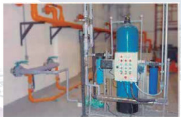
EDIFÍCIO COMERCIAL (SÃO PAULO-SP) TF-ACH-5000-UVB- SISTEMA DE FILTRAÇÃO DE ÁGUA DE CHUVA COMPLETO 5M 3 H
