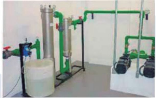
ARENA PORTO ALEGRENSE (PORTO ALEGRE-RS) TF-ACH-20000 - SISTEMA DE FILTRAÇÃO DE ÁGUA DE CHUVA 20M 3 H
