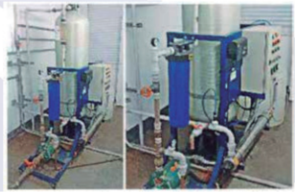
EDIFÍCIO COMERCIAL (RIO DE JANEIRO-RJ) TF-ACH-5000-UVB- SISTEMA DE FILTRAÇÃO DE ÁGUA DE CHUVA COMPLETO 5M 3 H
